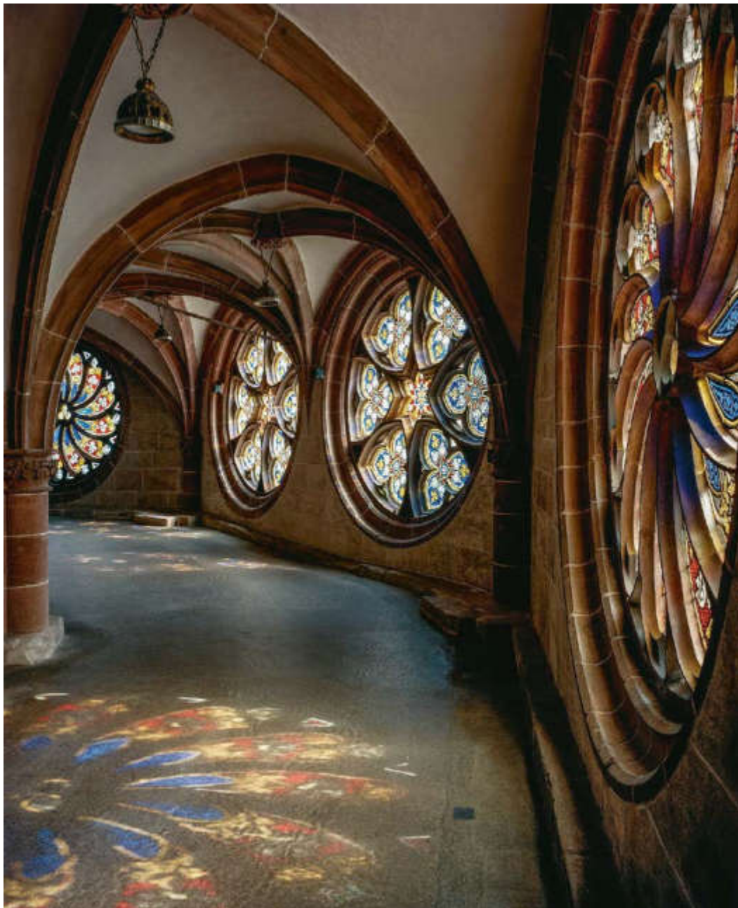
ABB. 210 Empore, Chorumgang. Grosse Rundfenster belichten die Empore, wobei der Scheitel des Umgangs durch zwei Fenster mit Masswerk aus Bogendreiecken hervorgehoben wird. Foto Erik Schmidt, 2006. DpfBS.
