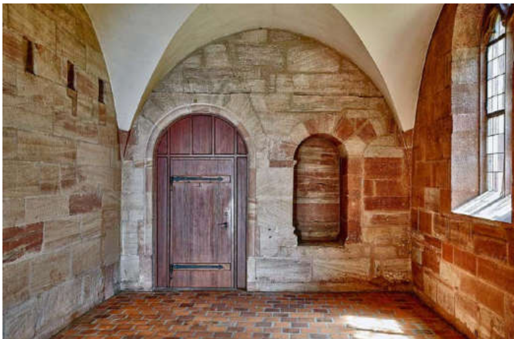
ABB. 450 Katharinakapelle, um 1470. Der eigentliche Kapellenraum liegt im Erdgeschoss und schliesst mit der östlichen Stirnwand an den Kreuzgang an, zu dem sich eine Tür und einst ein heute zugesetztes Biforium öffneten. Darüber ist die Nut für die Decke des flach gedeckten Vorgängerraums zu erkennen, dessen Deckenbalken in den rechteckigen Öffnungen in der Nordwand (l.) lagerten. Foto Peter Schulthess, 2018. DpfBS.
