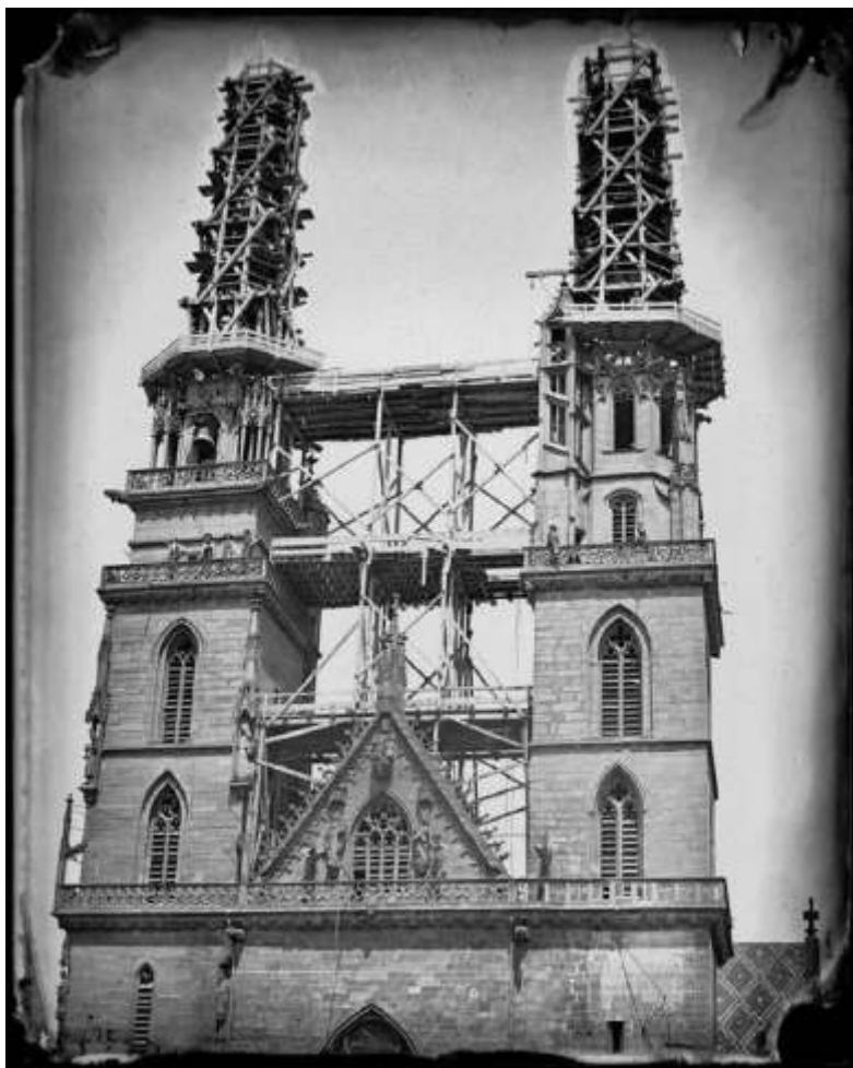
ABB. 122 Westfassade. Das kunstvoll-abenteuerliche Gerüst für die Turmsanierung während der Aussenrenovation von 1880/90. Foto Adam Varady. (StABS NEG 6498).
