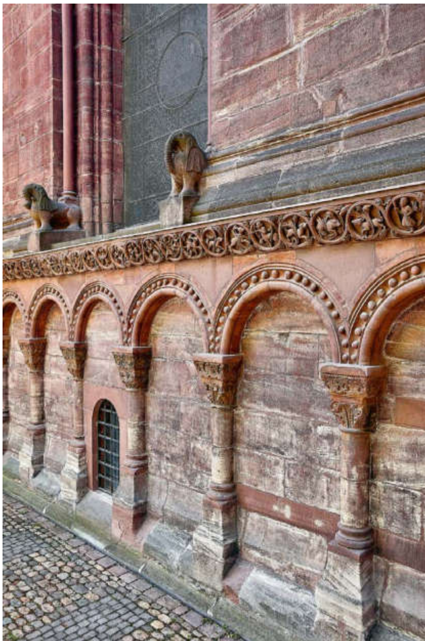
ABB. 194 Östliche Chorwand, um 1180, mit Blendarkatur auf Säulchen, Fries (Kopie) und zwei Elefanten (Kopien) als Säulenträger des Fensters. Die Säulchen stehen auf hohen Sockeln, die Kapitelle mit Palmettenornamentik sind durchwegs noch original erhalten. Foto Peter Schulthess, 2018. DpfBS.
