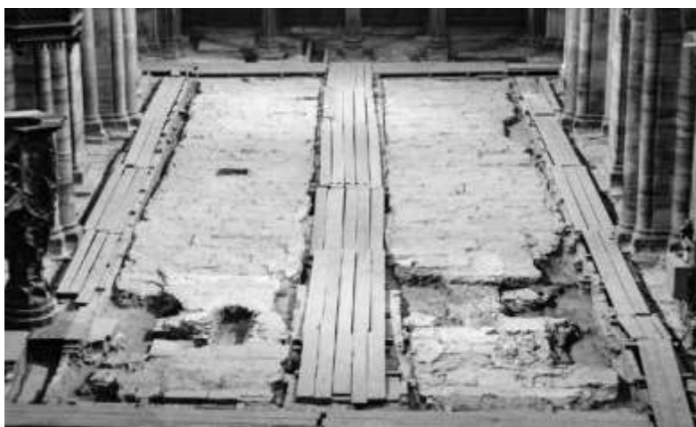
ABB. 60 Langhaus, Blick nach Westen. Freigelegtes spätromantisches Mörtelbett, 12./13. Jh. Gut sichtbar sind die Mörtelgrate zwischen den Negativen der unregelmässigen Steinplatten des spätromantischen Bodens. Foto Renato Celio, 1973 (ABBS 1974/29 HRS-F-05-043sw_05).
