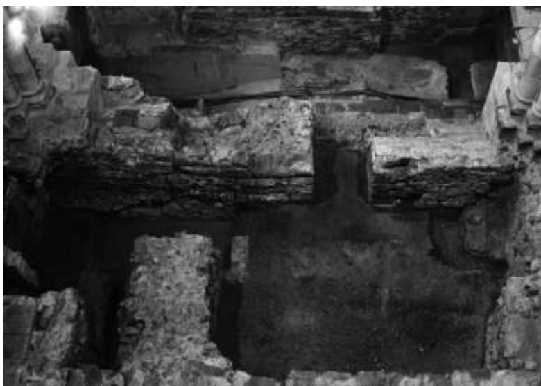
ABB. 50 Nördlicher Querhausarm, Vierung, Blick nach Süden. Die massive karolingische Fundamentmauer mit Durchgang zur am oberen Bildrand gelegenen Krypta. Das Mauerwerk enthält mehrere römische Spolien. Von links die anstossende frühromanische Fundamentverlängerung mit weitaus regelmässigerem Mauerbild, am unteren Bildrand das frühromanische Seitenschiffsfundament mit nach Süden ziehender (und durch einen jüngeren Grufteinbau durchschlagener) Fortsetzung. Foto Werner Stöckli oder Viktor Graf, 1966 (ABBS BS1966_sw-Mf_033_02).
