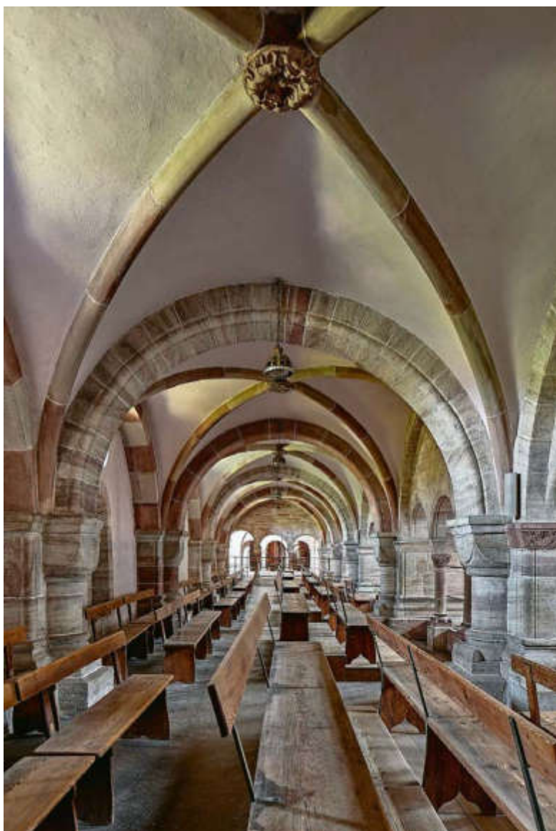
ABB. 211 Nördliches Seitenschiff, Empore, Blick gegen Osten. Die Wandvorlagen, Gurt- und Schildbogen gehören zum spätromanischen Baubestand, während die Gewölbe erst im 19. Jh. eingezogen wurden. Foto Peter Schulthess, 2018. DpfBS.
