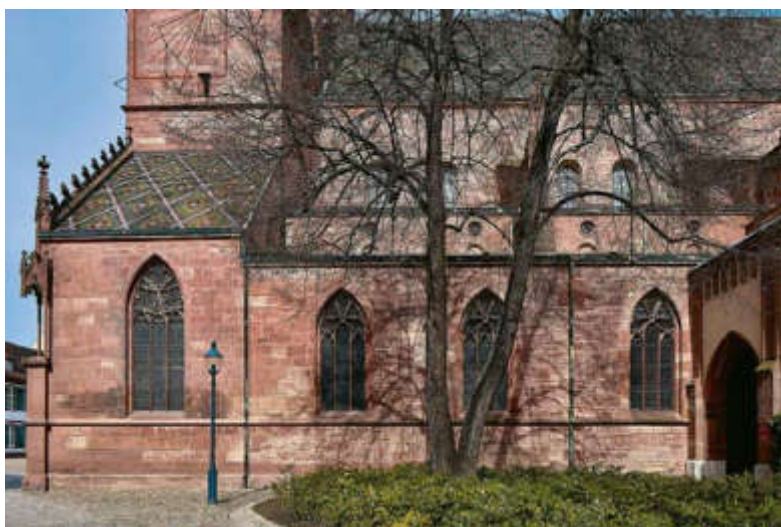
ABB. 95 Südliches Seitenschiff, nach 1300. Die Außenmauer zeigt ein über die ersten drei Kapellen durchgehendes Fugenbild. Nur im Sockelbereich erfolgt zwischen der Bebelnheim- und der Tegernaukapelle in den ersten vier Quaderschichten ein Lagenwechsel. Foto Peter Schulthess, 2018. DpfBS.
