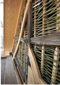
Flechtwerk (BILD 4), das anschliessend mit Strohlehm bestrichen wurde (BILD 5). Fotos 2012.
