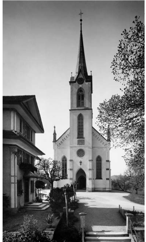
Udligenswil. Pfarrkirche St. Martin, 1874–1877 von Wilhelm Keller; 1964 abgebrochen. Foto von Emil Goetz, um 1920 (PA André Meyer, Luzern).
