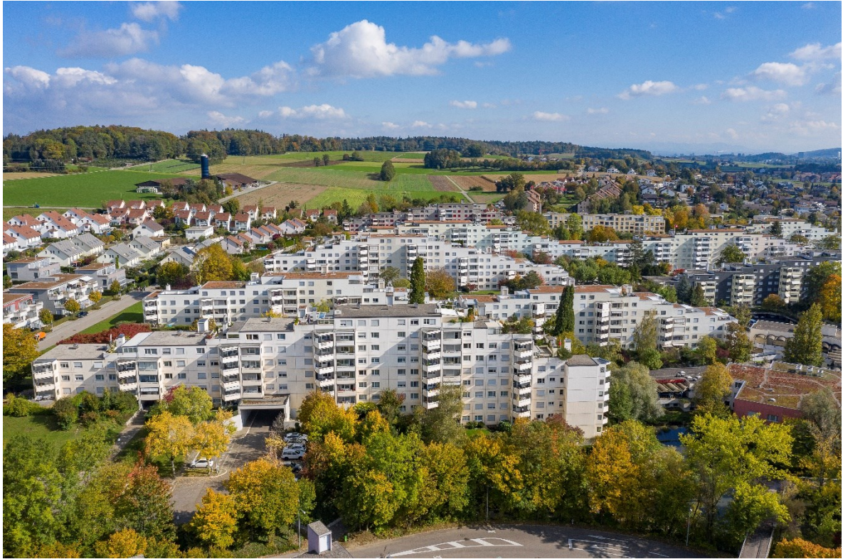
Adlikon bei Regensdorf, Siedlung Sonnhalde, erbaut 1969–1979. Foto Urs Siegenthaler.
