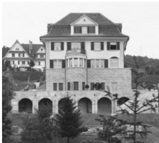
448 Restelbergstrasse 109. Villa Usenbenz. 1917 erbaut von Gschwind & Higi. Mit einer zweigeschossigen Substruktion wird die Hanglage kompensiert. Strassenseitig tritt der Bau als zweigeschossige Villa mit Mansardwalm- dach in Erscheinung. Foto 1918. BAZ. – Text S. 455.
