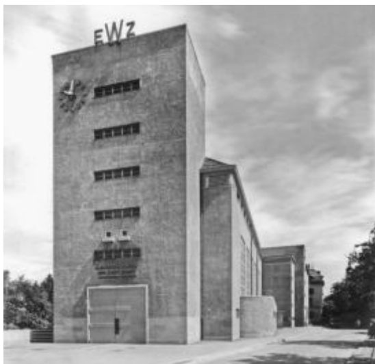
43 Selnastrasse 25. Ehemalige Umformerstation. Foto Wolf-Bender, um 1935. BAZ. – Text S. 94f.
