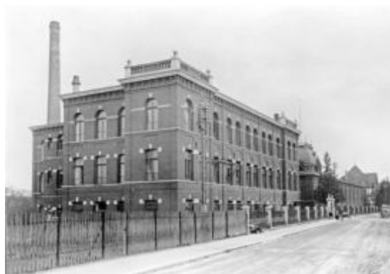
332 Seestrasse 395. Rote Fabrik, ehemalige Wäscherei. Foto um 1910. BAZ. – Text S. 356f.
