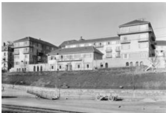
423 Wasserwerkstrasse 106, 108, Imfeldsteig 2, 4–6. Frauenwohnkolonie Lettenhof. Ansicht über die heute aufgehobenen Gleise bei der Bahnstation Letten. Foto Ernst Linck, um 1928. BAZ. – Text S. 436f.
