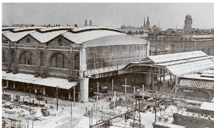
Um 1930 ist die Wanner-Halle zu eng: Vor ihr wird eine Querhalle erstellt, an der sich mehr Gleise anbinden lassen. Ein Provisorium – es steht noch heute.
