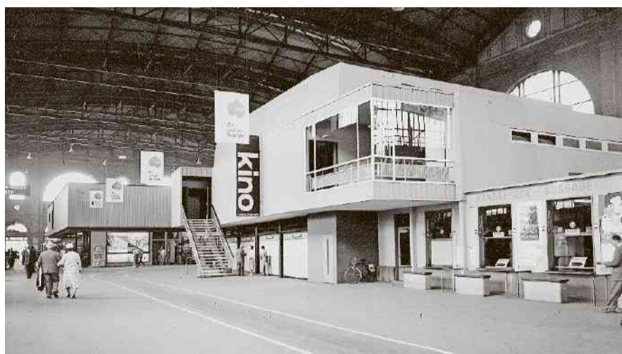
Die Wanner-Halle war, nachdem die Gleise verschoben waren, über Jahrzehnte hinweg mit Bauten verstellt.
