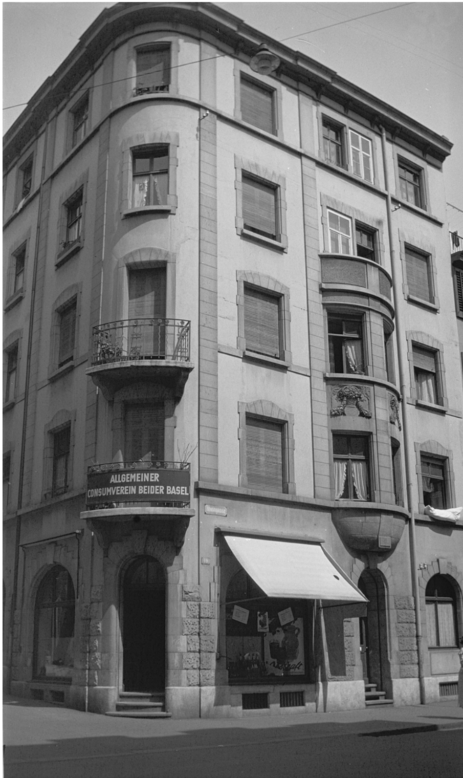
Der ehemalige Laden des Allgemeinen Consumvereins ACV (1936), wo sich heute die Bar Consum befindet. (Bild: Staatsarchiv BS / NEG 4824)
