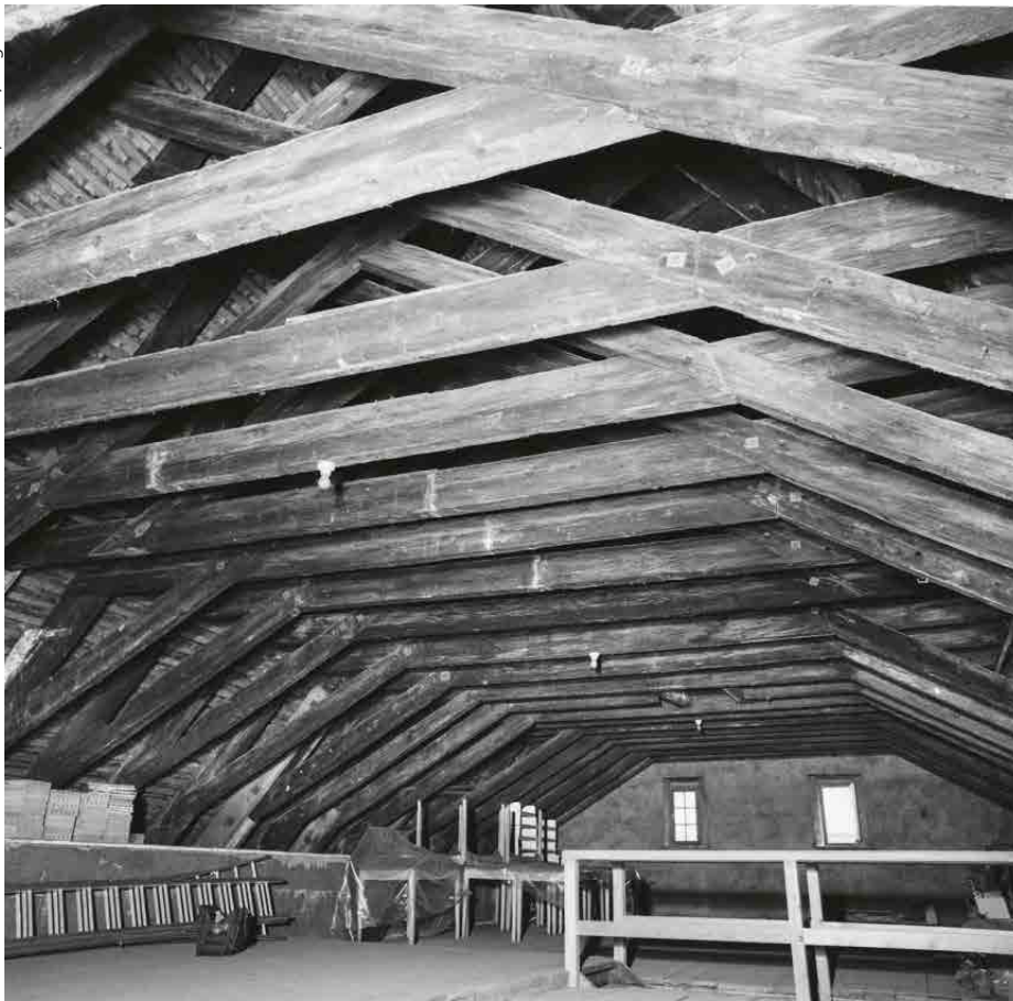
Einer der ältesten erhaltenen Dachstühle in Basel in Form eines gotischen Sparrendachs. Es ist zimmertechnisch anspruchsvoll, da es durch Kehlbalkenlage und Kreuzstreben keine Stützbalken im Raum benötigt. Seit 700 Jahren versieht es seinen Dienst im «Schönen Haus».
