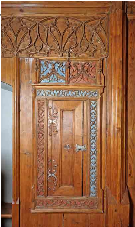
Nadelberg 4, Engelhof. Wandschrank in der Nordwand des Condézimmers. Die schmale Tür mit zierlichen, in Eichenlaub und Eicheln endenden Bändern wird von durchbrochenen Masswerkfriesen gerahmt.
