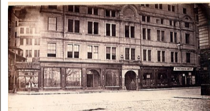
La maison Andrion (démolie) à la rue de du Rhône. BGE
