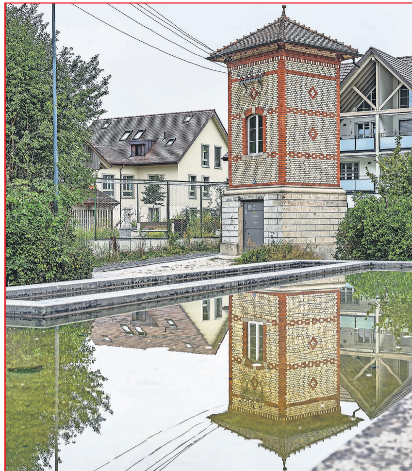
Das 1998 erneuerte Rechteckbecken des Kirchbrunnens, die 1908 von der Elektrizitätsgenossenschaft Rümlang erbaute Trafostation. Bild: Urs Siegenthaler, 2020
