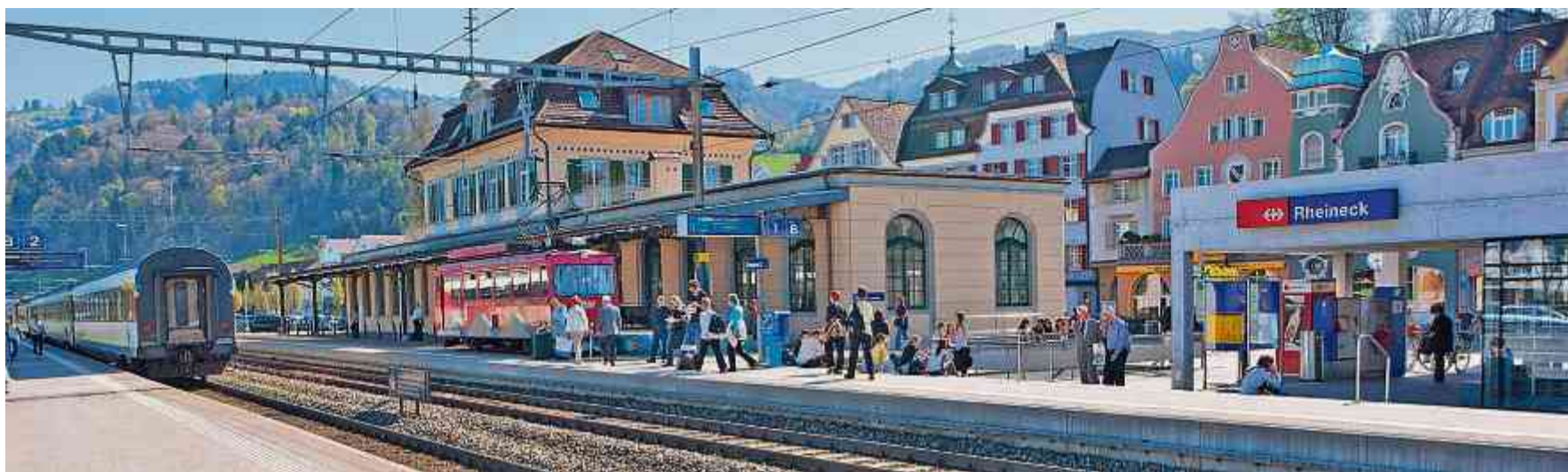
Der Bahnhof Rheineck soll durch mehrere Massnahmen von Stadt und SBB aufgewertet werden.
