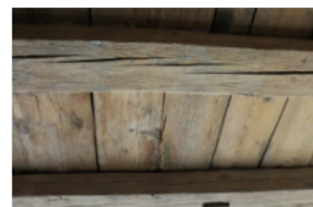
Holzverbindungen im Dachgebälk des Scherbenhofs
