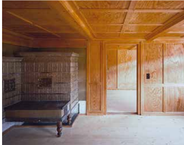
Das Brendlehaus im liechtensteinischen Schellenberg mit Baujahr 1815 wurde 2005 – 2006 mit der angegliederten Scheune energetisch instand gestellt und ausgebaut. Die Verbesserungsmassnahmen konzentrierten sich auf die Gebäudehülle, wobei die bauphysikalischen Herausforderungen im Wärme- und Schallschutz bei gleichzeitigem Substanzerhalt bestanden.
