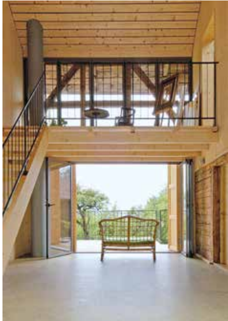
Das Brendlehaus im liechtensteinischen Schellenberg mit Baujahr 1815 wurde 2005 – 2006 mit der angegliederten Scheune energetisch instand gestellt und ausgebaut. Die Verbesserungsmassnahmen konzentrierten sich auf die Gebäudehülle, wobei die bauphysikalischen Herausforderungen im Wärme- und Schallschutz bei gleichzeitigem Substanzerhalt bestanden.
