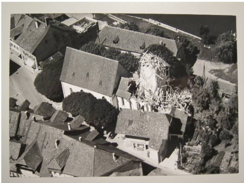
Die Kirche Büren an der Aare nach der Schicksalsnacht 1963. (Bild: Denkmalpflege des Kantons Bern)
