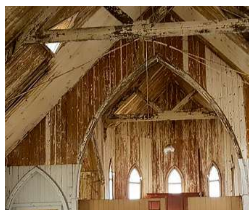
Innen eine stabile Holzkonstruktion: Blick in Richtung Apsis der ehemaligen Kirche.
