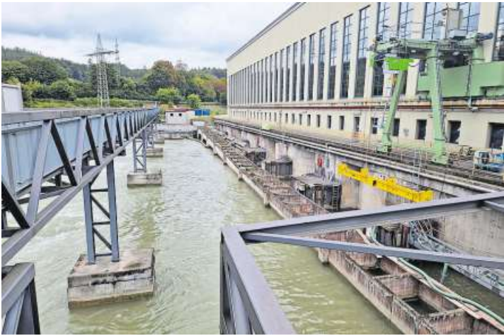
Auch das Kraftwerk Ryburg-Schwörstadt war in die Umstellung der Verteilnetzleitungen eingebunden. Bild: Mira Güntert
