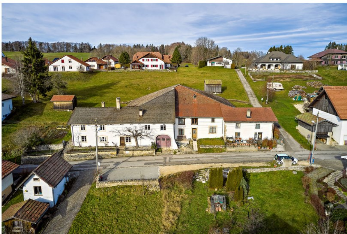
La toiture à quatre pans de la ferme a connu quelques rénovations à travers les siècles. (Photo : SHAS, Dirk Weiss © gsk.ch).
