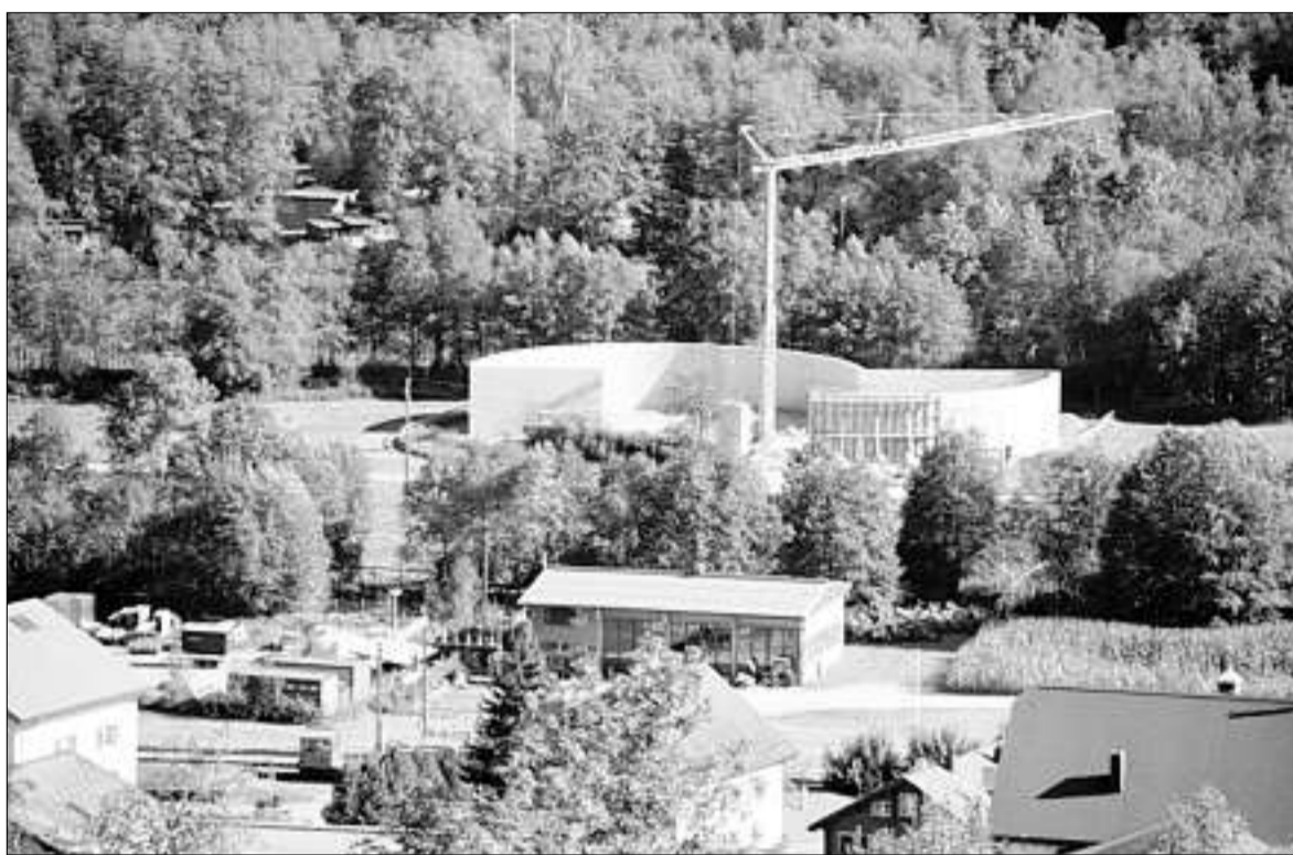
Noch gilt es, eine Lücke in der Betonwand zu schliessen, dann sind die Bauarbeiten am Projekt «Ogna» abgeschlossen, das eine besondere künstlerische Attraktion werden wird. (zVg)
