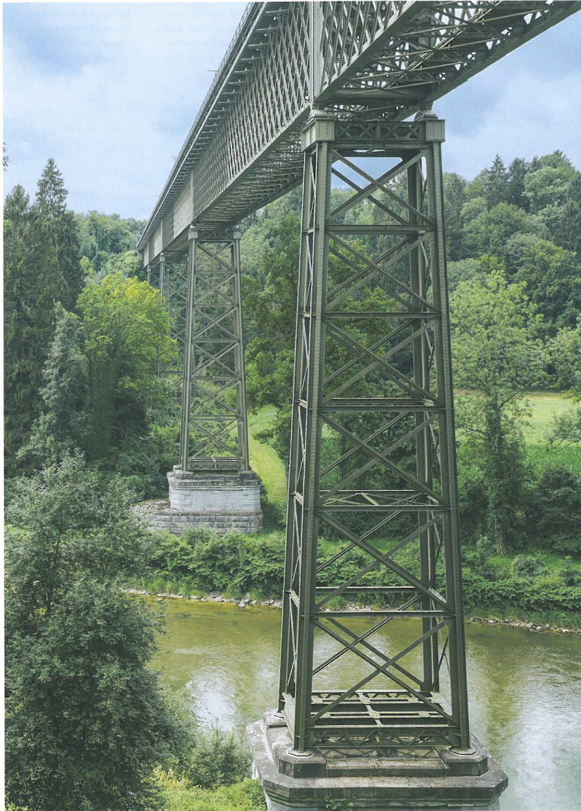
Die Thurbrücke Ossingen von 1875 ist die letzte Schweizer Bahnbrücke mit eisernen Pfeilern, die noch in Betrieb ist. Sie ist zudem mit einer Gesamtlänge von 332 m und einer Höhe von 42 m die grösste historische Stahlbrücke der Schweiz. (Foto: Georg Aerni)
