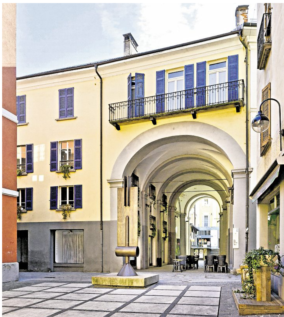
BELLINZONA La Galleria Benedettini come è oggi e come era in passato.
